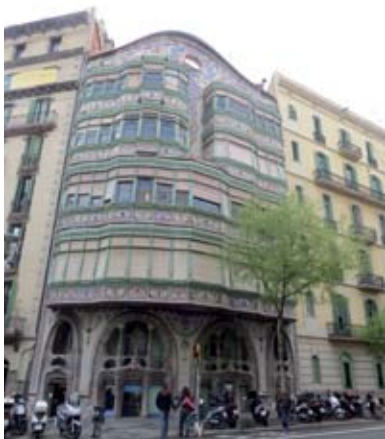
Fig. 5 - Detall decoració façana carrer Còrsega. (Fot. Inés Padrosa)
